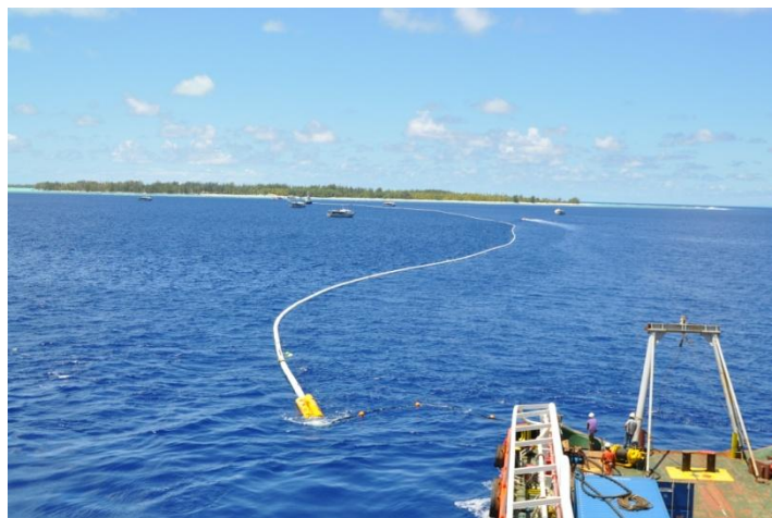
Sea Water Air Conditioning – Arrivée du pipeline d'aspiration sur Tetiaroa en Polynésie française © Pacific beachcomber
