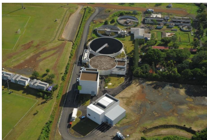
Station d'épuration Dumbéa 2 en Nouvelle-Calédonie © Martial Dosdane – province sud
