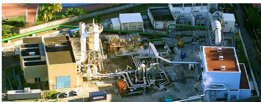
Centrale géothermique de Bouillante en Guadeloupe © BRGM
