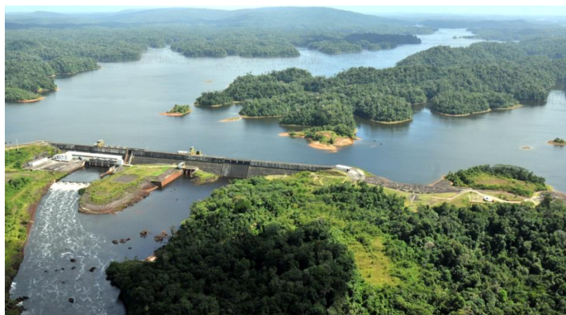
Barrage de Petit-Saut en Guyane © EDF
