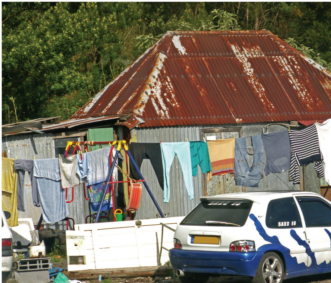
Logement dégradé commune de Cilaos
