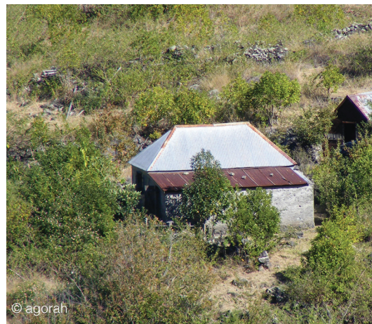
Logement dégradé commune de Cilaos
